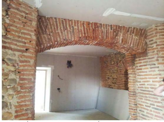
RECUPERACIÓN DEL ARCO DE ACCESO AL TORREÓN CEGADO Y ADINTELADO CON EL PASO DEL TIEMPO
