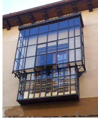
LIMPIEZA Y RECUPERACIÓN DE MIRADORES, SUSTITUYENDO LOS VIDRIOS EXISTENTES POR OTROS DE SEGURIDAD
