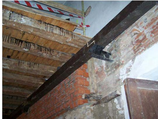
APOYO DE LAS CABEZAS DE LAS VIGAS DE MADERA SOBRE VIGA METÁLICA PARA SOLVENTAR LA PÉRDIDA DE CAPACIDAD MECÁNICA POR PUDRICIÓN
