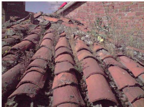
ESTADO INICIAL DE PARTE DE LAS CUBIERTAS QUE HAN TENIDO QUE SER SUSTITUIDAS, REAPROVECHANDO AL MÁXIMO LOS ELEMENTOS EXISTENTES
