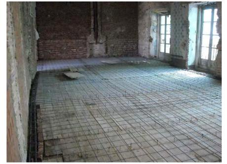
REFUERZO DE FORJADOS DE MADERA CON LOSA ALIGERADA DE HORMIGÓN Y CONECTORES METÁLICOS
