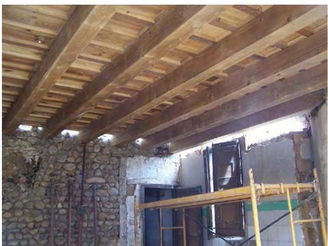
ESTADO FINAL CON FORJADOS MIXTOS DE MADERA Y HORMIGÓN ALIGERADO
