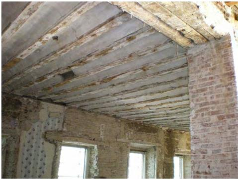
ESTADO INICIAL DEL FORJADO DE MADERA CON BOVEDILLAS DE REVOLTÓN
