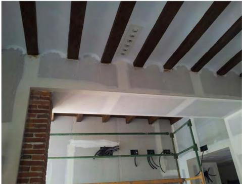
ESTADO FINAL DEL FORJADO CON LA LIMPIEZA Y REPARACIÓN DE LA MADERA Y LAS BOVEDILLAS DE REVOLTÓN
