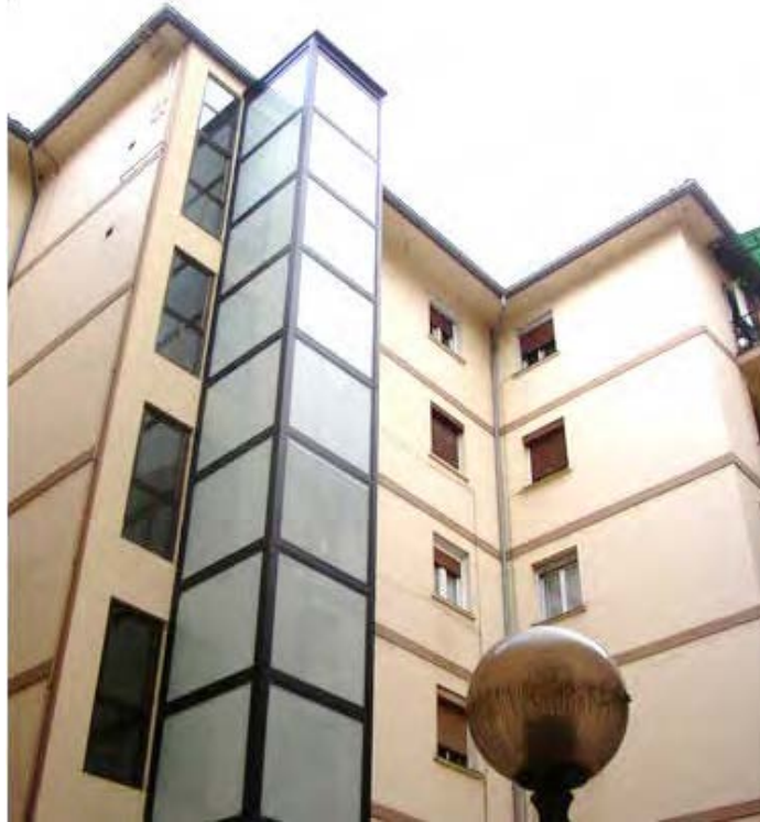
Ilustración 19: Ejemplo de intervención de colocación de ascensor exterior.
